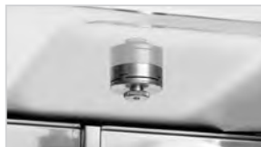
▶ Stoomgeneratoren: directe inspuiting
